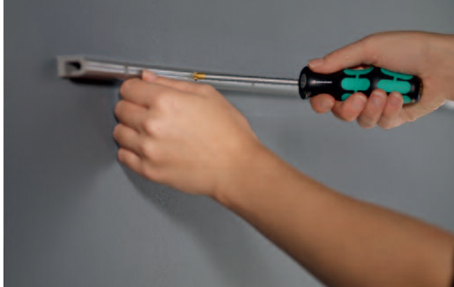
Kunststoffschiene an der Wand befestigen ...
